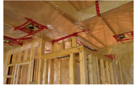
프레데터 리조트의 빌라 공사현장
